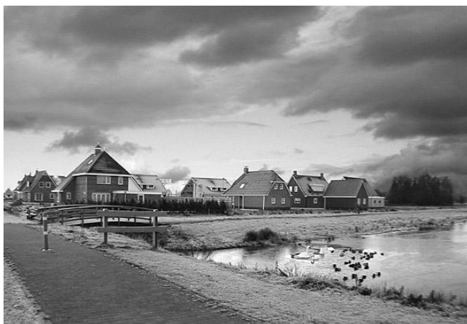
Figuur B-2: Woningen in aanbouw in Munewyk
